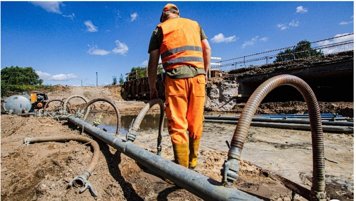
Streckenertüchtigung: Bei den Bauarbeiten östlich des Bahnhofs von Bad Freienwalde kontrolliert ein Bauarbeiter die Grundwasserabsenkung, die für die Fundamentarbeiten notwendig ist.
